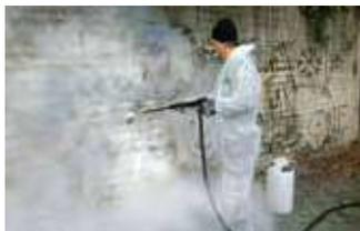
**Graffiti Waster** est un générateur de vapeur portable, équipé d'une chaudière à mazout, qui permet d'éliminer les graffitis et la saleté en général, grâce au système révolutionnaire qui utilise de la vapeur/sable et de la vapeur/détergent mélangés. Idéal pour enlever tout type de graffiti des murs, des bâtiments, des sols, pour la restauration et le nettoyage des statues/monuments, pour le sablage des murs et des balustrades.
